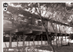
Núcleo do PPGAU da Faculdade de Arquitetura | 1980 Arquiteto: João Figueiras Lima - Lala Endereço: Rua Carlos Motta, 121 - Federação
