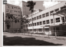
Faculdade de Enfermagem | 1958 | Arquiteto: Endereço: Rua Dr. Augusto Viana, s/n - Canela
