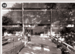
Instituto de Física | Início da década de 1970 Arquiteto: Equipe de Serviço de Engenharia do Campus Universitário da UFPA Endereço: Rua Barão de Jeremoabo, s/n - Ondina
