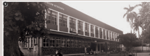
Escola de Medicina Veterinária | 1920 Arquiteto: Avenida Adhemar de Barros, 300 - Ondina
