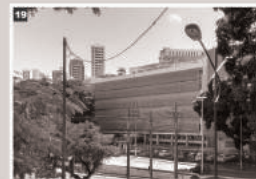
Instituto de Ciências da Saúde (ICS) | Década de 1950 | Arquiteto: Equipe de Professores do Campus Endereço: Avenida Getúlio Vargas, 1272 - Canela
