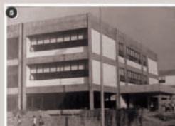
Pavilhão de Aulas Rector Felipe Serpa (PAF III) | Segunda metade da década de 1970 Arquiteto: Eduardo Teodoro Adornato da UFPA Endereço: Rua Barão de Jeremoabo, 147 - Ondina
