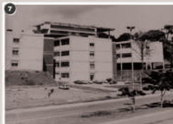
Instituto de Geociências (IGEO) | 1960 Arquiteto: Equipe de Serviço de Engenharia do Campus Universitário da UFPA Endereço: Avenida Adhemar de Barros, s/n - Federação
